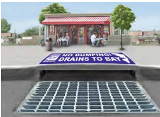
Alcantarilla: una alcantarilla externa que desemboca directamente en los arroyos y la Bahía.
